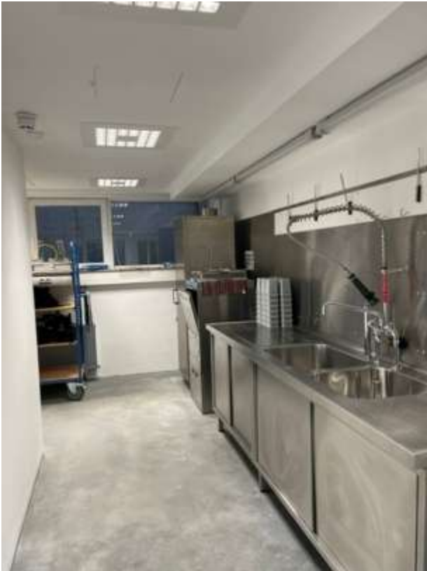
Neuer Estrich und Wände eingebaut
